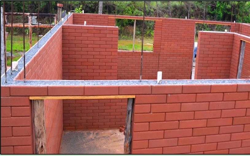
➔ Não é mais necessário gastar dinheiro com madeira na sua construção. As tábuas das caixarias são substituídas pelos tijolos canaleta que desempenham a mesma função, servindo de molde para as vigas.
