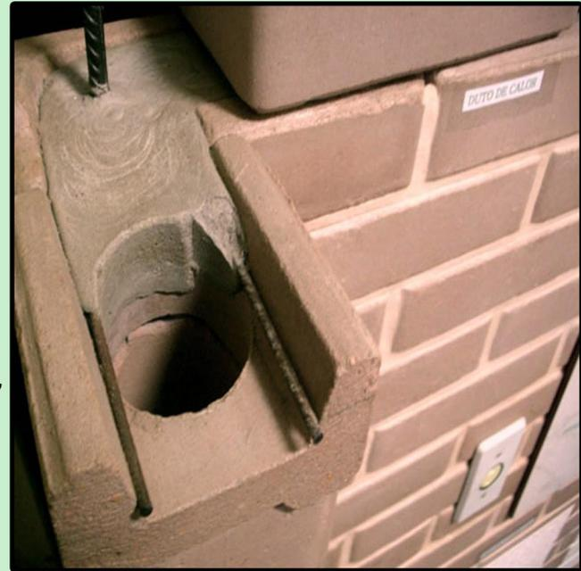
➔ Da mesma forma os furos do tijolo ecológico servem de molde para as colunas de sustentação, que já ficam naturalmente embutidas nas paredes, não comprometendo o acabamento estético.
